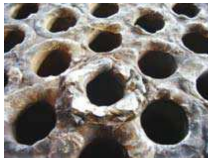
a) actual welding joints
